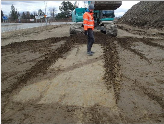
Kaivannon poikki menevä oja. Kuva Itään.
